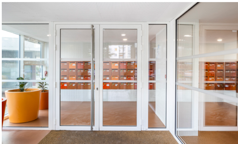
©G.Ayer - Résidence Binquenaïs, après réhabilitation.
