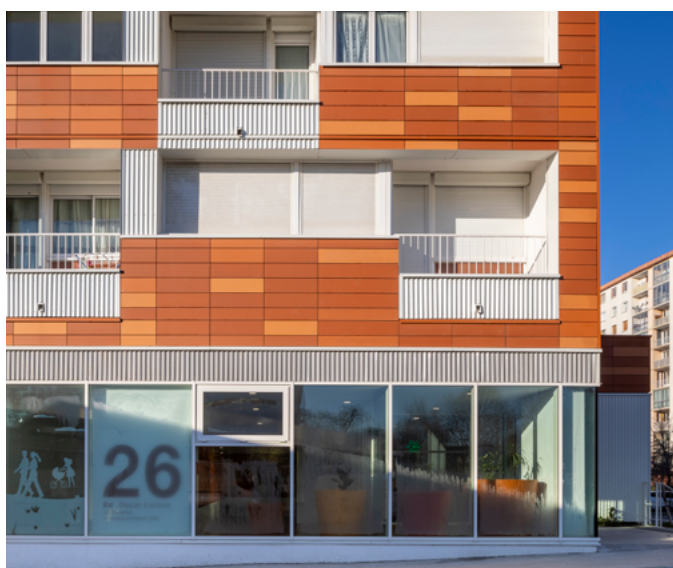
©G.Ayer - Résidence Binquenaïs, après réhabilitation.
